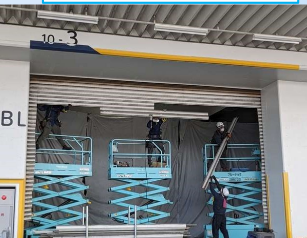
外部シャッター施工風景
