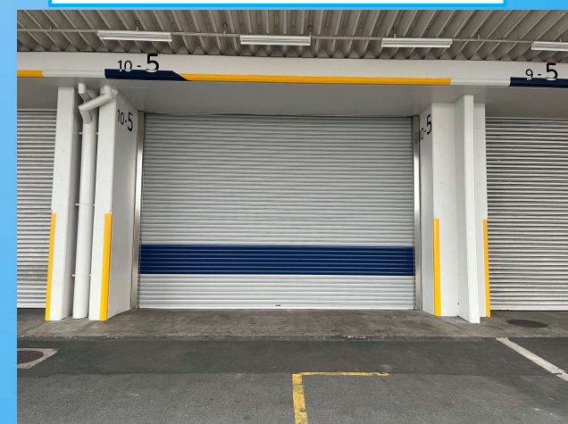
外部シャッター更新後
