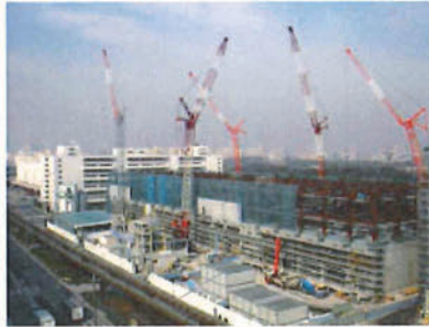
写真2 施工状況(2期工事)
