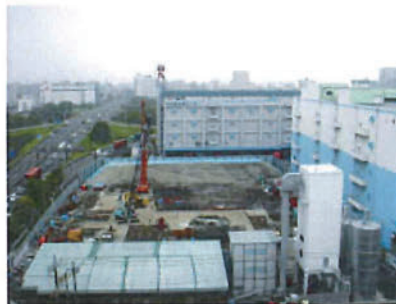
写真5 生コンプラント(3期工事)
