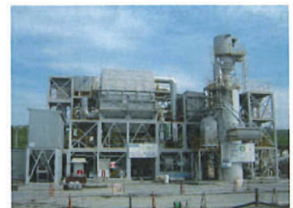
写真6 再生骨材プラント(中央防波堤)
