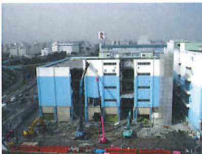
写真4 解体状況(3期工事)
