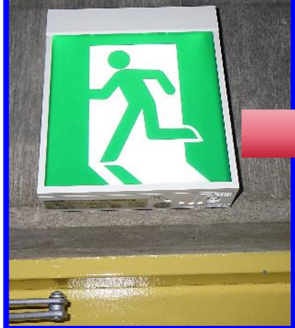
工事前(避難口誘導灯)
