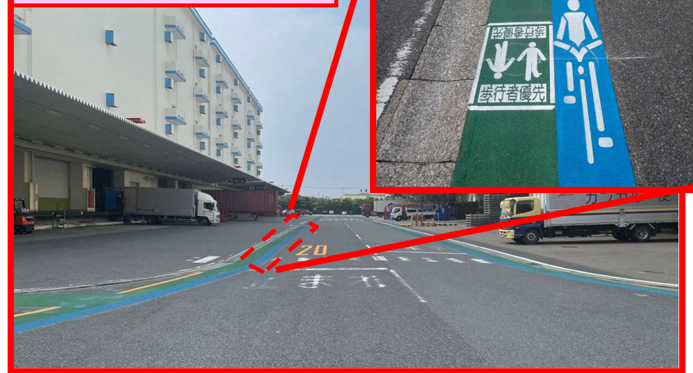
工事後(グリーンベルト舗装補修)
