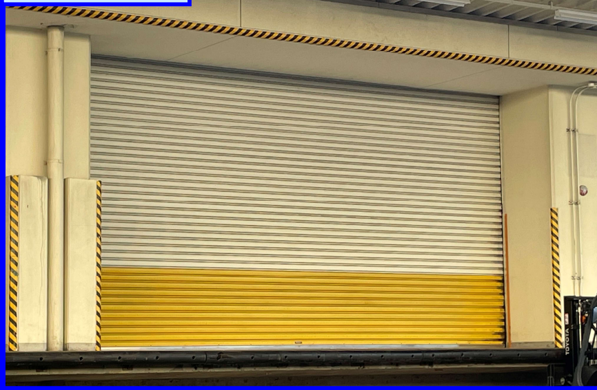
外部シャッター外観
