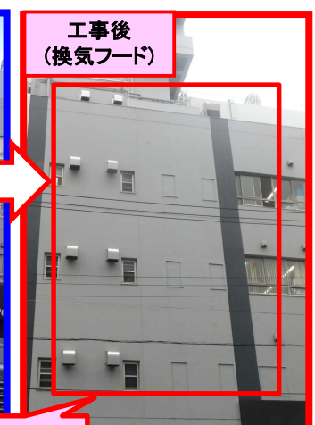
換気フード取替・撤去
