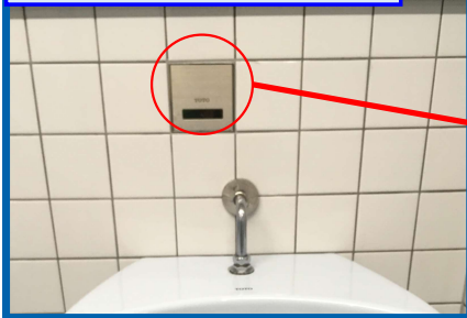
工事前 (小便器自動洗浄弁)
