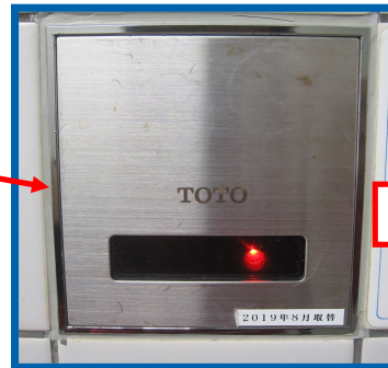
工事後 (光電センサー取替)
