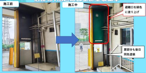
倉庫棟1階、リングシャッター脇の出入口のサイン塗装工事を7/10(土)より実施しております。以前、庫内の**消火栓・消防隊進入口・階段室入口**の上部を対象に赤・黄・緑の各色で塗装を行りました。今回の施工箇所は緊急時の選難誘導サインとして、階段室出入口や防火シャッター脇くぐり戸と同じ緑色に塗り上げます。庫内の誘導灯や今回のサイン塗装は、緊急時の迅速な避難、ひりては人命にかかわる重要な標示ですので、庫内の導線を今一度確認頂き、選難の妨げとなるものは移動して頂きますよう、宜しくお願り致します。
