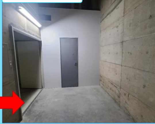
ボード壁・鋼製扉設置
