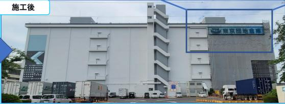
倉庫棟北面の外壁工事を実施しております。他の面と同様、防水補修工事を実施し たうえで、テザイン性を考慮した塗装を行っております。テナント各社様の社名表記も 新調し、奇数号棟側に青の矢印、偶数号棟側に黄色の矢印を追加しましたので、新 規入構者にもわかり易くなったかと思います。偶数号棟側に残っている足場は5月中に 解体完了予定です。また、これに併せて外部照明を更新・追加しましたので、夜間の 北面駐車場周りが明るくなり、安全性も向上しております。
