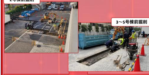
給水設備更新工事は雨天により順延しておりました、2 号棟前車道横断部分の新規給水メイン配管の設置が完 了致しました。今後は8月の給水切替までに庇下に新規 給水配管を順次吊り込みますので、ご協力をお願い致し ます。
