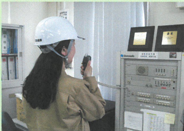
12時15分 訓練開始を知らせる緊急通報状況（管理室非常放送設備より）
