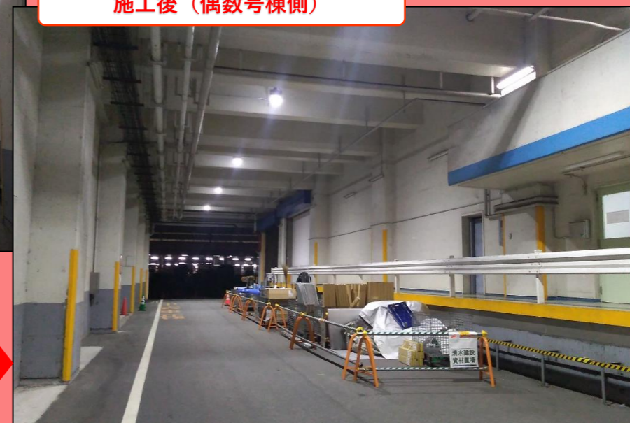
施工後（偶数号棟側）
