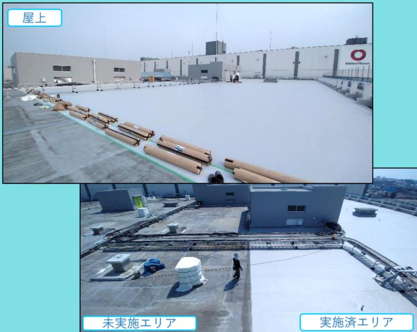
倉庫棟の壁面で防水塗装工事を実施しているのと同様、屋上でも**防水工事**を進めております。これまでも部分的な防水補修工事は行ってまいりましたが、今回は屋上の全床面と各塔屋を対象とし、**庫内への雨水侵入を防ぎます**。加えて既存の屋上の仕様に比べると、今回の防水シートは**遮熱性の向上**が期待できる素材を採用しています。
