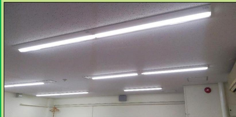
庫内のLED照明に引き続き、各棟**事務所内照明器具のLED化工事**を進めております。庫内LED照明器具と同じく**消費電力の低減**が見込めるほか、耐用年数も大幅に伸びます。皆様のご助力により、多数のテナント様でLED化作業進行しており、出来高としましては、倉庫内及び事務室内で全体の**7割程度**が取替済みとなっております。引続きのお荷物のご移動等ご協力をお願い致します。
