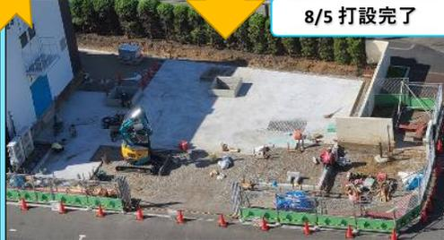
管理棟休憩スペースの改修工事が進行中です。7月号でお伝えした植栽の伐採・抜根ののち、既設の自販機置き場、通路などコンクリート部分の撤去を行い、整地しました。そののち、型枠を作成し基礎コンクリート打設を行いました。作業は10月頃まで継続実施しますので、今後ご理解ご容赦の程、宜しくお願い致します。
