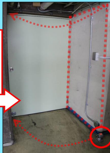
各棟**1階・中2階**の防火シャッター脇扉に**マグネットキャッチ設置工事**を実施しております。平常時は磁力で固定され扉は開いていますが、火災を感知すると磁力が切れて扉が閉まり、**防火区画を形成**するようになっております。平常時は**ドアキャッチ部のボタンを押して磁力を切って閉じる**ことも可能です。ドアストッパー等の障害物で自動閉鎖が出来ないと、火災発生時の延焼に繋がります。マグネットキャッチで常開にできますので、古いドアストッパーがあれば撤去頂きますよう、お願い致します。
