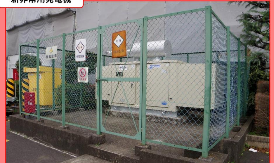
停電発生時の自家用発電機として、倉庫棟北側の**非常用発電機更新工事**を実施致しました。発電機の負荷は**屋内消火栓ポンプ、加圧給水ポンプ、メンテナンス用乗用ELV**に電源を供給できます。貨物用ELVへの電源供給には使用できませんので、ご承知おき下さい。
