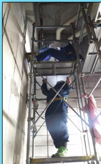
現在使用していない配管の撤去や電気配線の取替を行う為、物置内壁面を解体しております。作業時は大きな音が発生するため、ご迷惑にならないよう施工場所・タイミングを調整しております。ご承知おきください。
