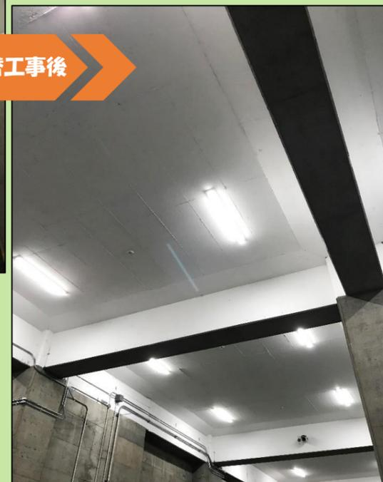
大規模リニューアル工事で、倉庫内のLED照明器具は既設品よりもスペックの高い5200lmの器具を採用しています。照度(平均)も取替前:130lx→**取替後:215lx**に上がっており、写真の通り明るくなりました。
