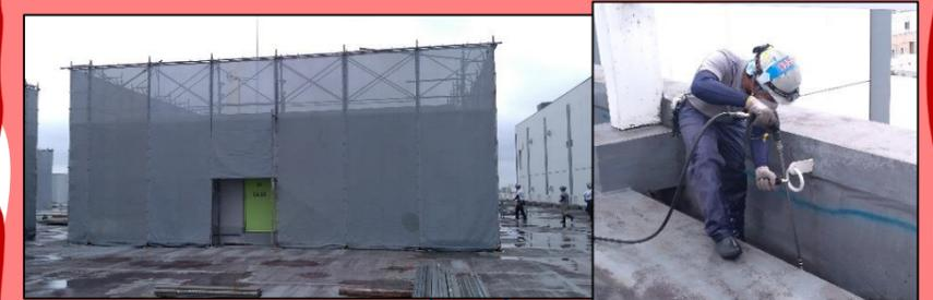
1工区では屋上防水工事の準備が着々と進んでおります。各機械室の足場組みが完了し、屋上床面は高圧洗浄で綺麗に掃除しています。
