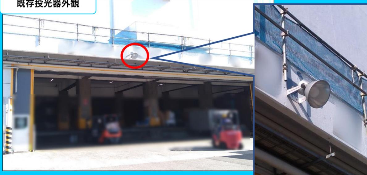
各号棟前**底部および外壁の投光器照明LED化工事**を新規追加工事として予定しております。既存照明と比較し**構内全体照度向上**のほか、LED化に伴う**省エネ効果**により、共用部電力の低減も見込んでおります。仕様や更新時期は現在検討中となっておりますので、決定次第改めてア+ウンスをさせていただきます。
