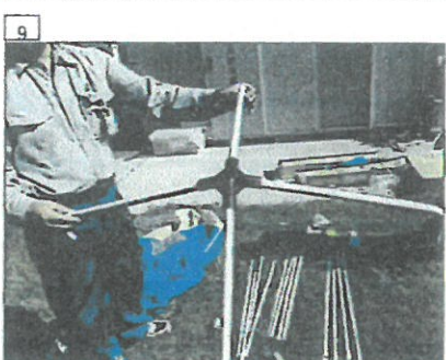
9 テント骨組の組立
