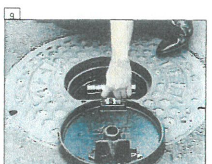
9 汚水が全て流れきるまでレバーを上げた状態で維持する
