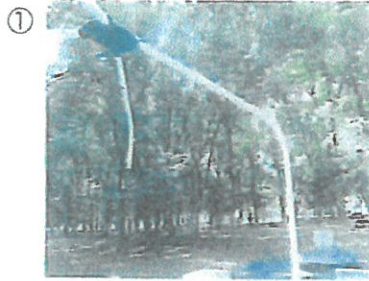
① 曲げパイプに柱パイプを差し込みます。
