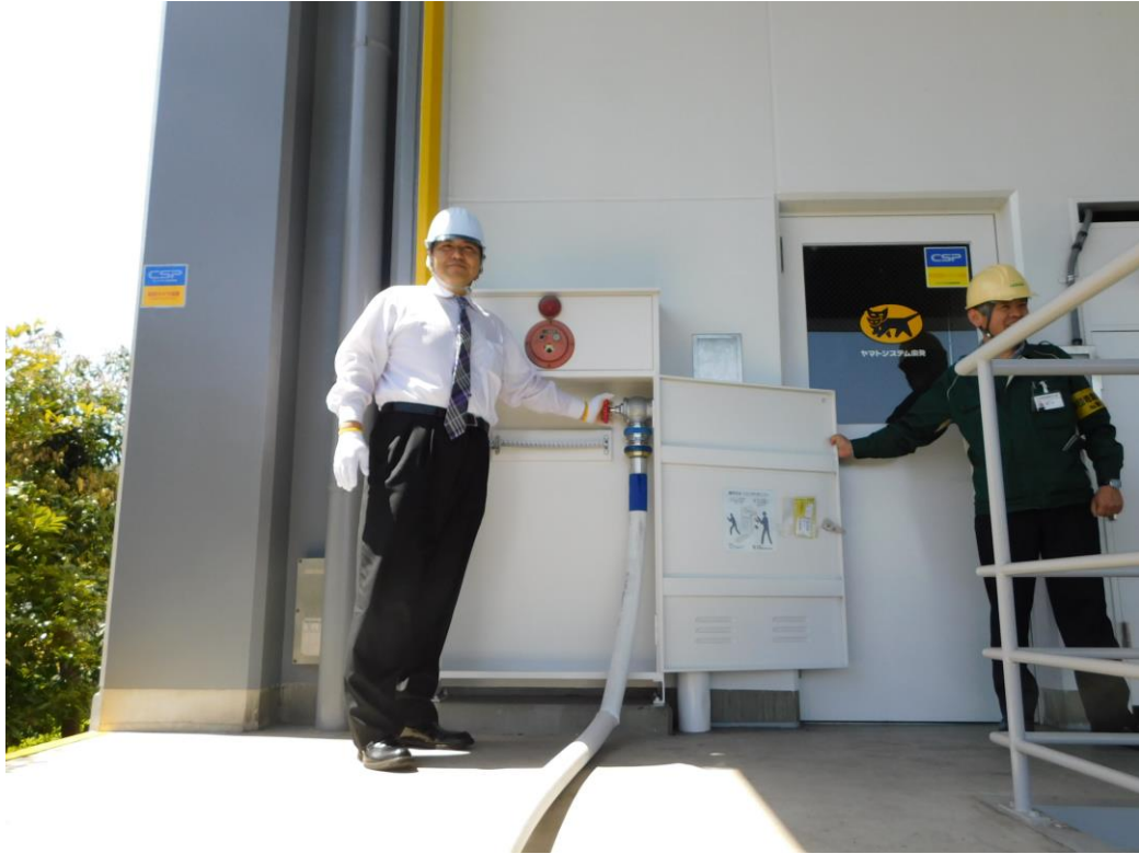
屋外消火栓バルブ開放
