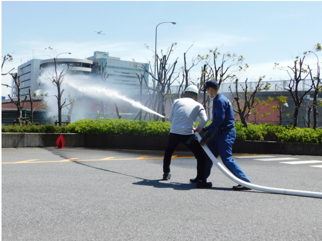
屋外消火栓放水開始
