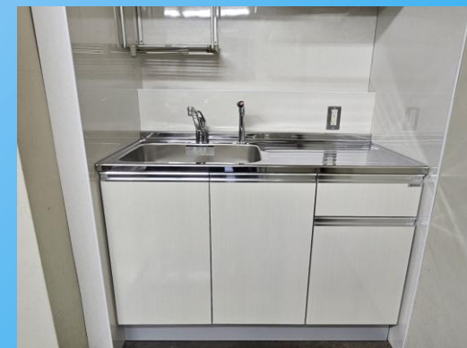
ガス給湯撤去・電気給湯設備設置工事
