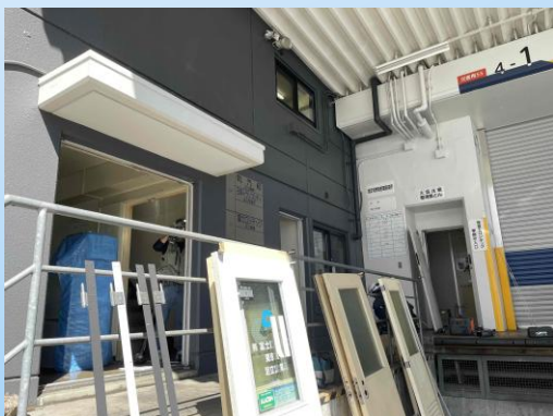
主要建具補修・更新工事状況 (鋼製建具更新工事)
