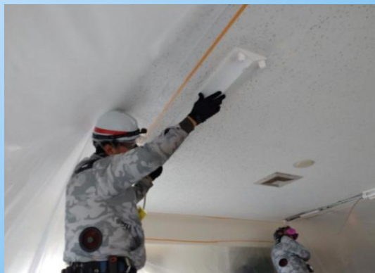
照明器具LED化・ コンセント更新工事状況
