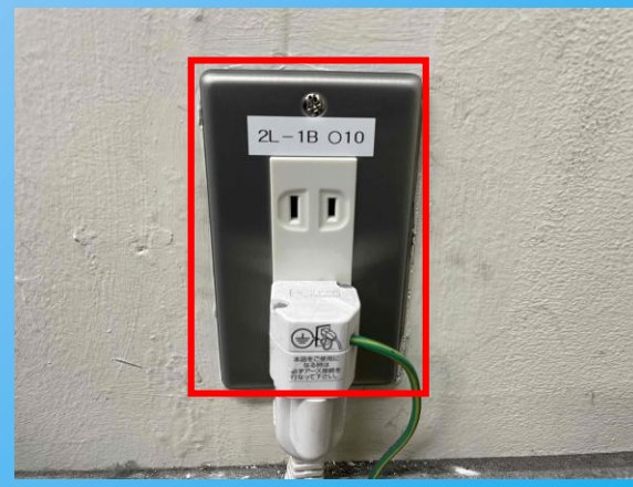
コンセント更新工事状況
