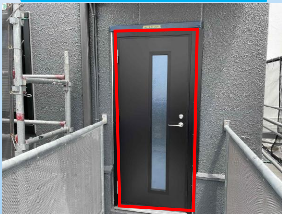
主要建具補修・更新工事状況① (附属事務棟アルミ扉更新後)
