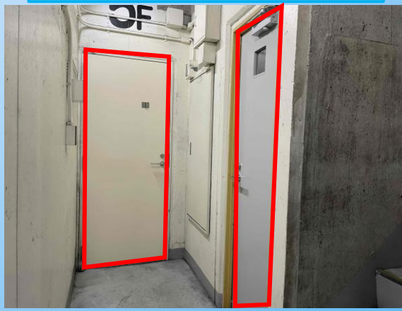
主要建具補修・更新工事状況② (鋼製建具更新工事)
