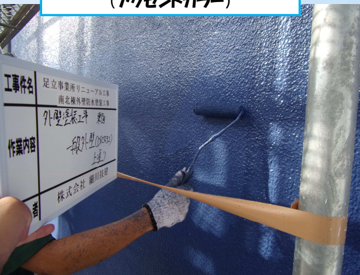
北棟外壁仕上げ塗装 (アクセントカラー)
