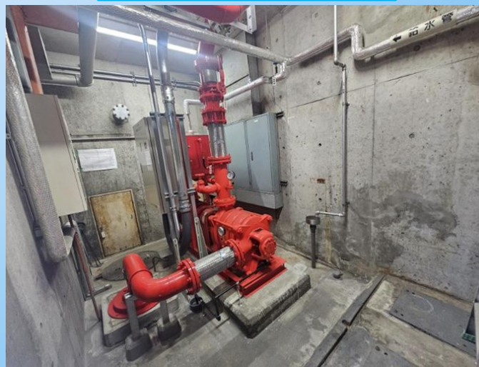
消火栓ポンプ更新状況
