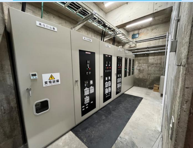
北棟第1電気室新設キュービクル完成状況
