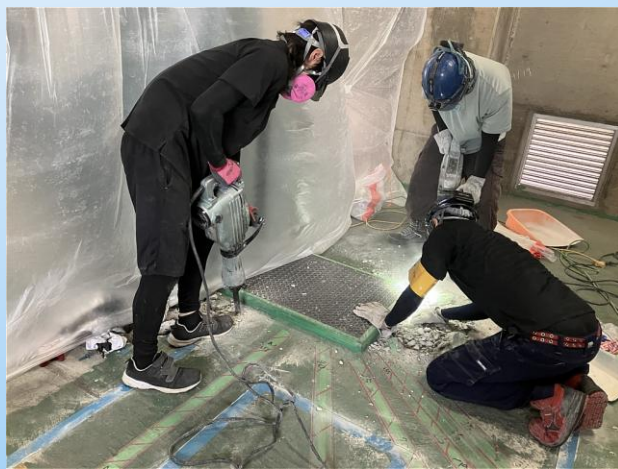
エレベーター準撤去更新工事 (ELV機械室内床ハツリ)
