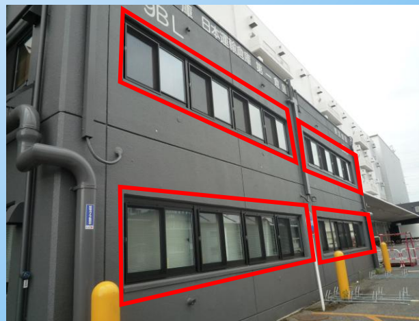
主要建具補修・更新工事状況① (附属事務棟アルミサッシ更新後)
