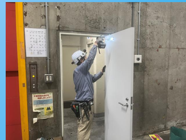
主要建具補修・更新工事状況② (鋼製建具更新工事)
