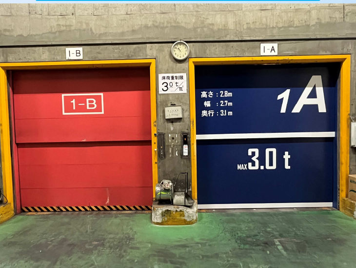
1階ELV乗場扉更新
