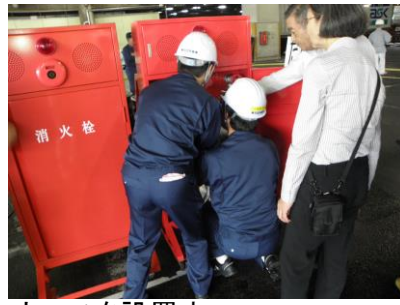
ホースを設置中
