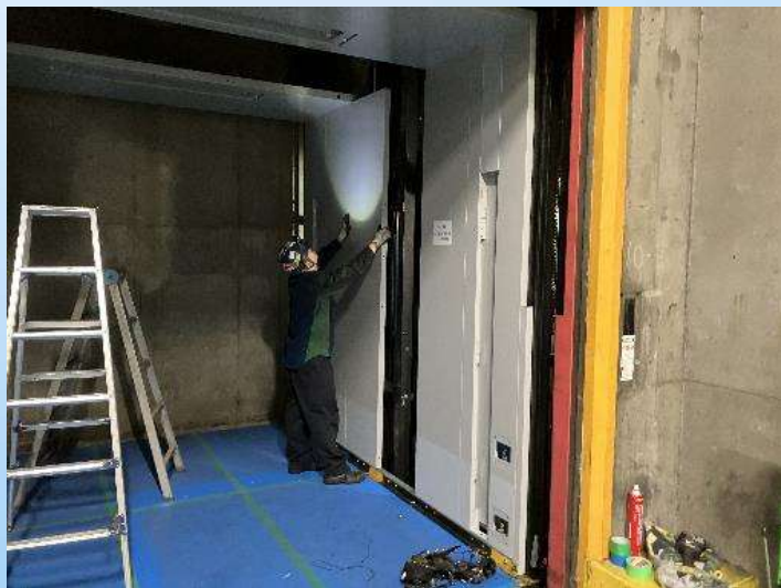
ELV乗りかご内室組立作業
