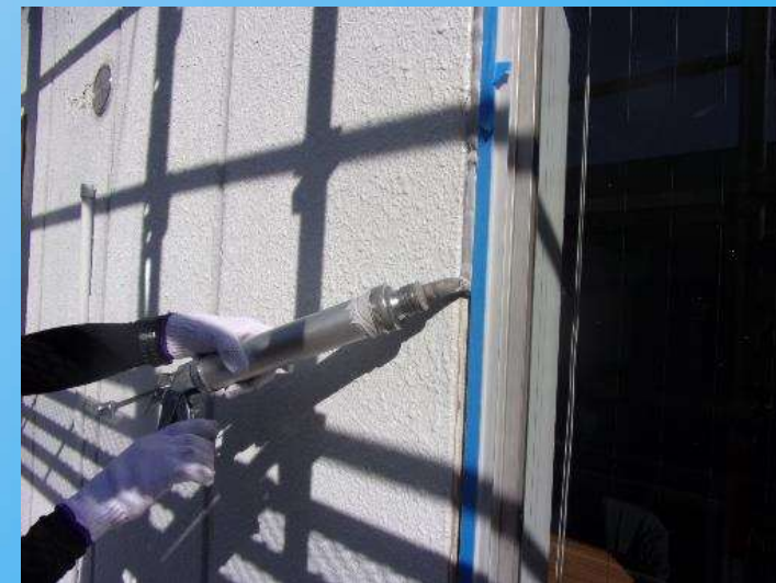
北棟附属事務棟シーリング工事
