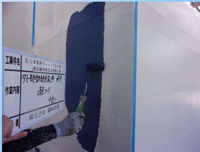
北棟換気扇カバー鉄部塗装
