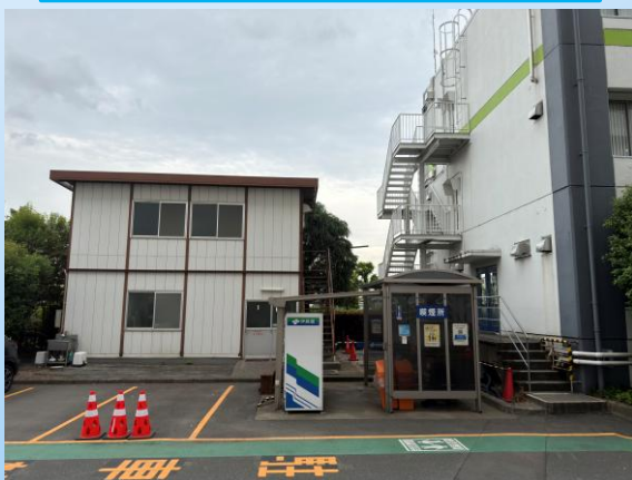
管理棟横設備撤去対象箇所
