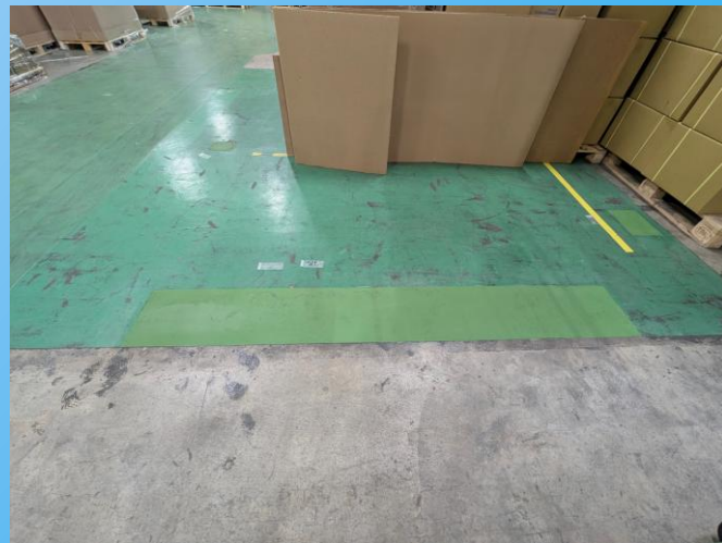
庫内床補修状況
