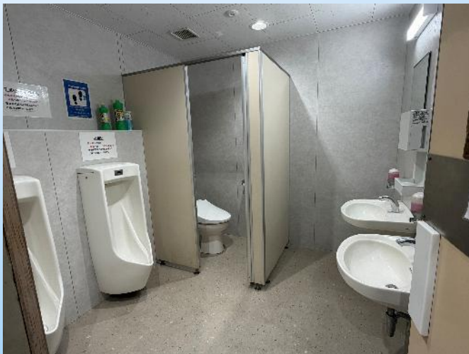
管理棟トイレ更新状況
