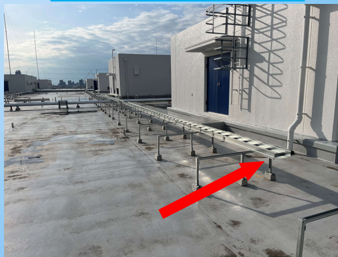
屋上ケーブルラック施工風景
