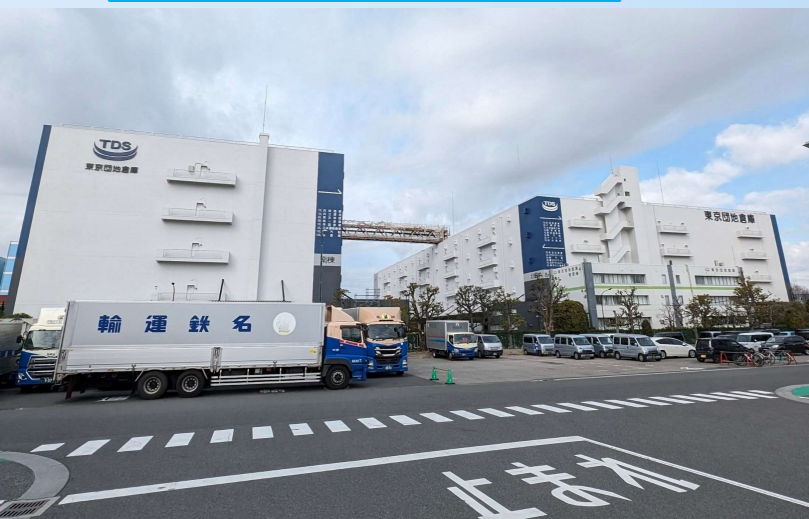
外壁仕上げ塗装完了
