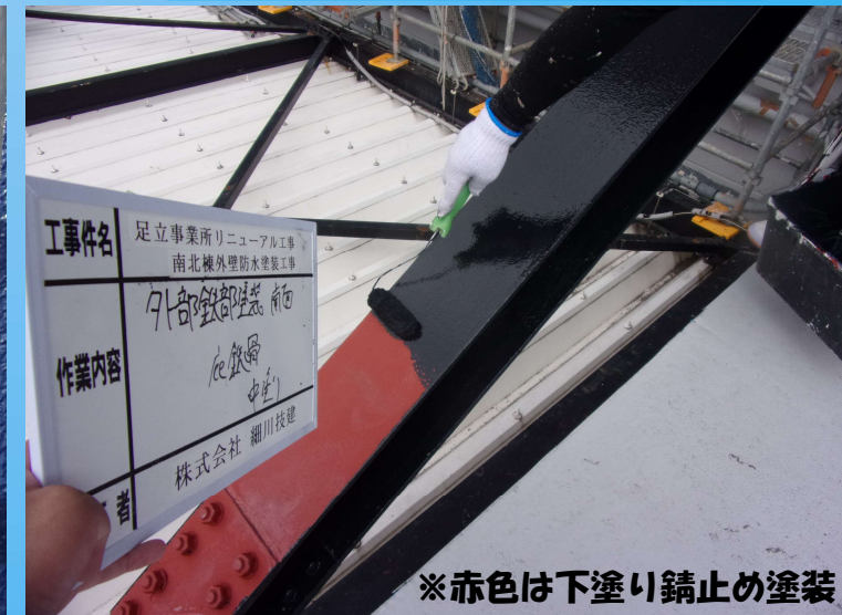
北棟底鉄骨塗装
