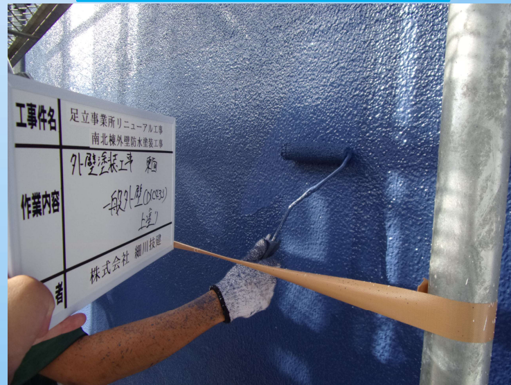
北棟外壁仕上げ塗装
