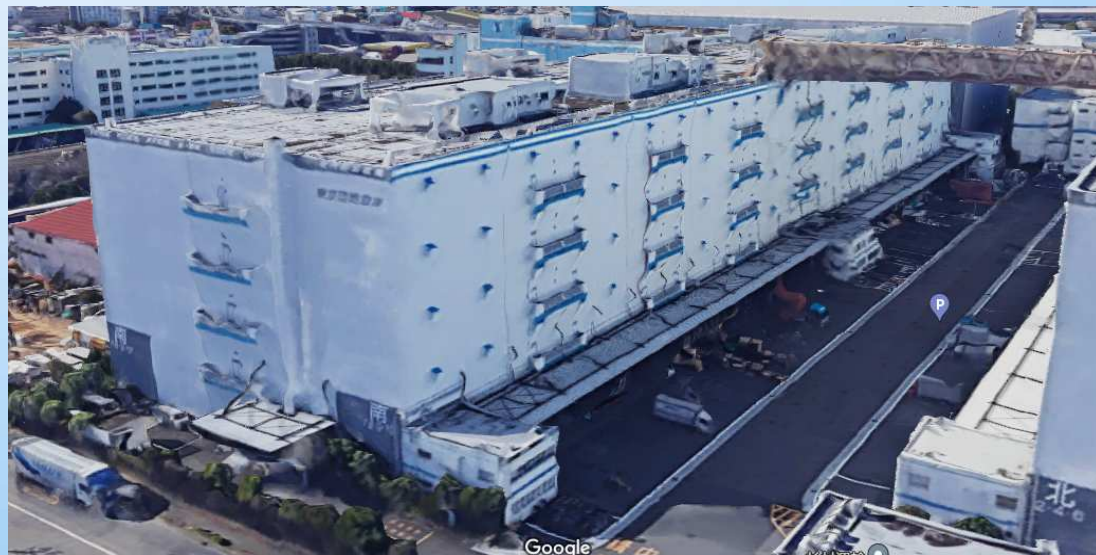
仮設足場施工前
