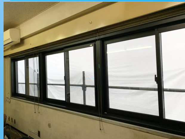
主要建具補修・更新工事状況③ （アルミサッシ更新作業）
