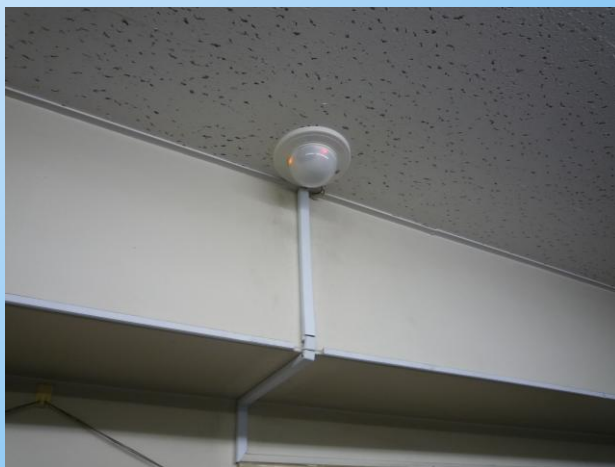
主要建具補修・更新工事状況② （パッシブセンサー取付作業）
