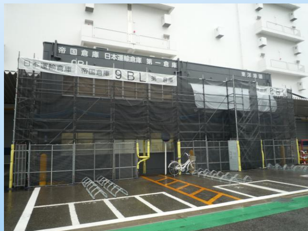
主要建具補修・更新工事状況① （附属事務棟足場架設）
