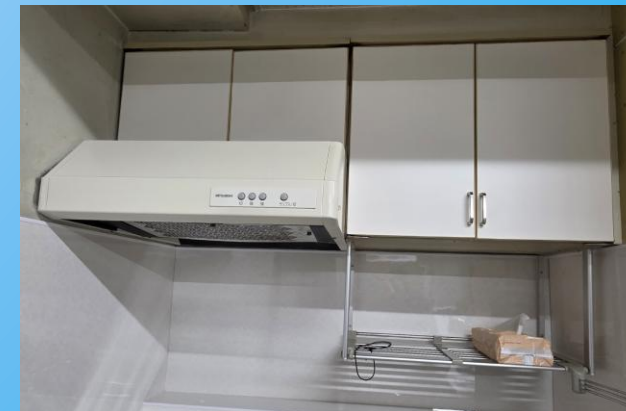
ガス給湯撤去・電気給湯設備設置工事 上部棚美装化状況
