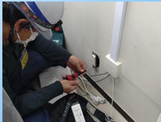
照明器具LED化・ コンセント更新工事状況
