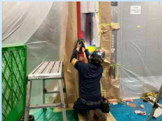
エレベーター準撤去更新工事状況 (三方枠塗装)
