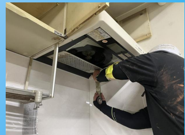
ガス給湯撤去・電気給湯設備設置工事清掃状況
