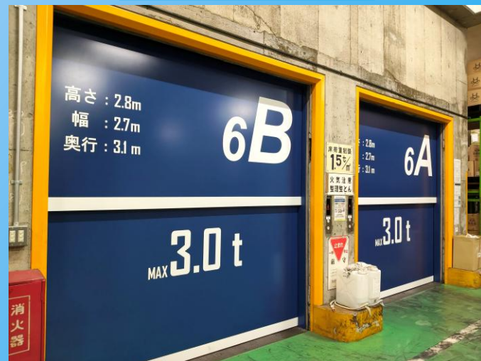
庫内ELVサイン施工状況
