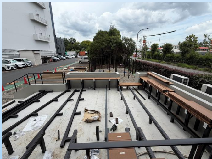
管理棟横テラス設置状況
