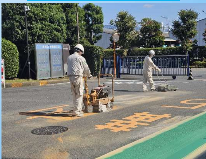
正門前 舗装サイン施工状況
