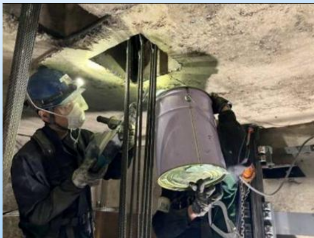
エレベーター準撤去更新工事状況 巻上ロープ撤去
