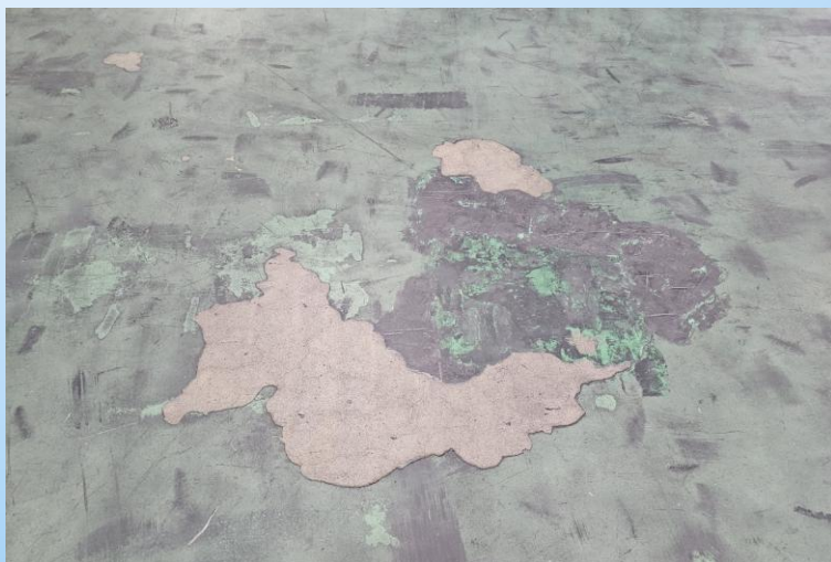
庫内床補修工事 対象箇所
