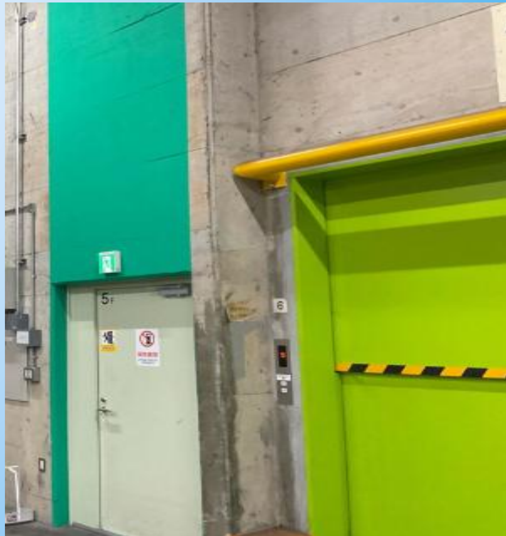
庫内サイン表示工事 施工イメージ (参考：板橋事業所)
