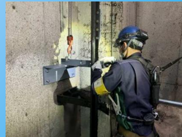
エレベーター準撤去更新工事状況 補強材取付
