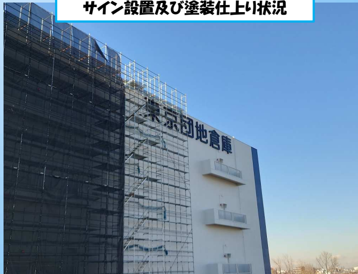
北棟外壁足場解体後 サイン設置及び塗装仕上り状況
