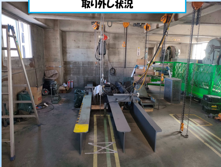
ELV機械室巻上げ機 取り外し状況
