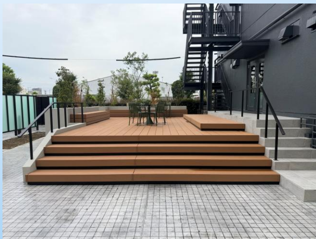
管理棟横テラス完成状況
