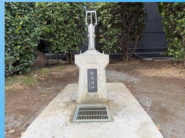
管理棟横防災用井戸設置状況
