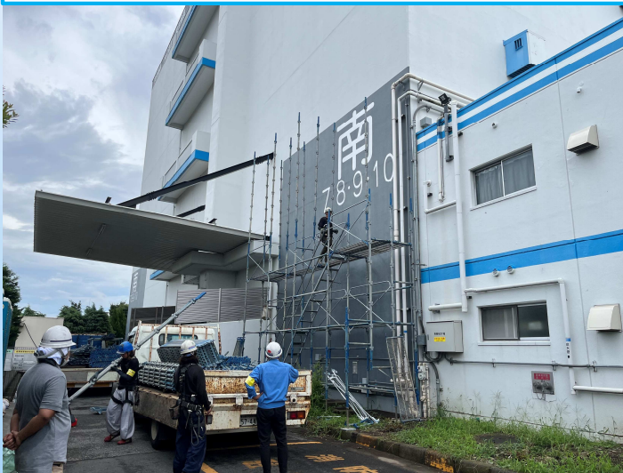
仮設足場設置状況(南棟東面)
