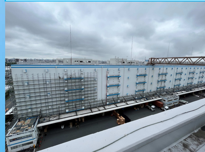
9月9日時点進捗状況(南棟北面)
