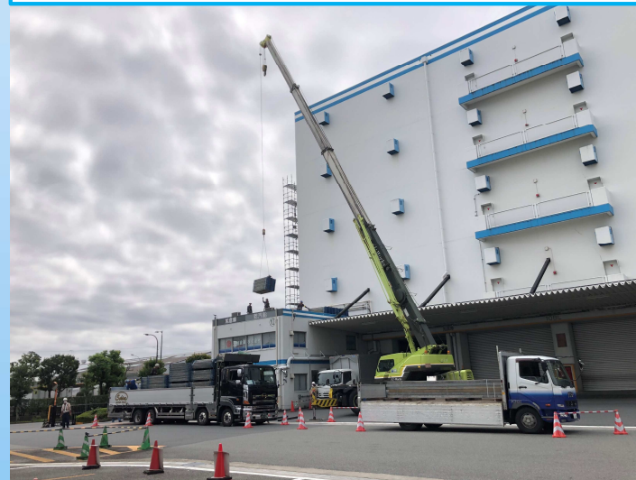
足場材揚重状況(土日祝作業)
