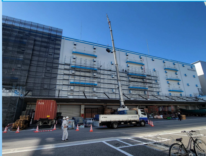
足場材揚重状況(土日祝作業)
