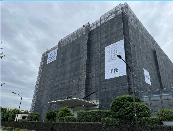
仮設シート看板設置状況(南棟東面)
