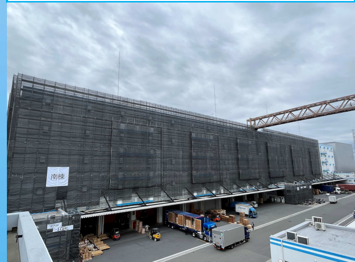
10月12日時点進捗状況(南棟北面)
