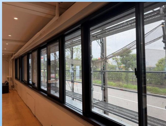
管理棟サッシ更新状況
