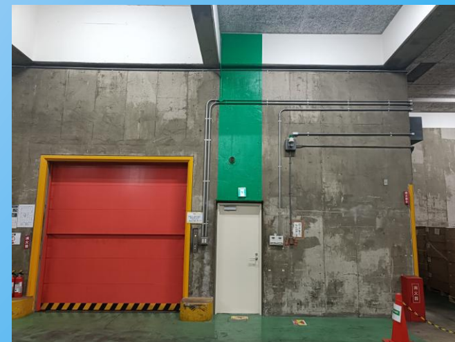
庫内サイン施工状況
