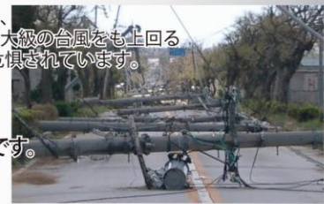
2003年台風14号の強風被害 (写真：宮古島地方気象台)
