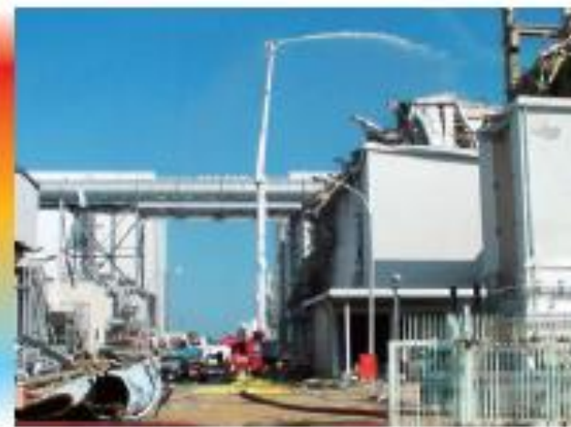
屈折放水塔車による3号機への注水
