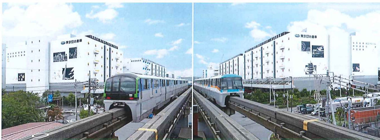
東京団地倉庫株式会社 平和島事業所 C 棟と A-2 棟（モノレール搭乗時イメージ）
