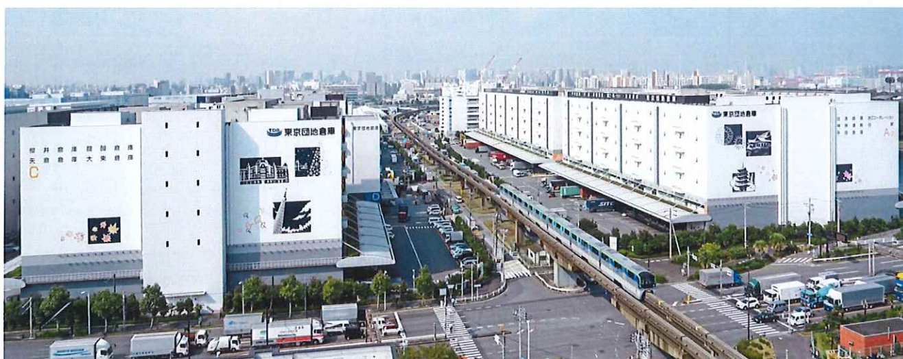
東京団地倉庫株式会社 平和島事業所 C 棟と A-2 棟（俯瞰写真）
