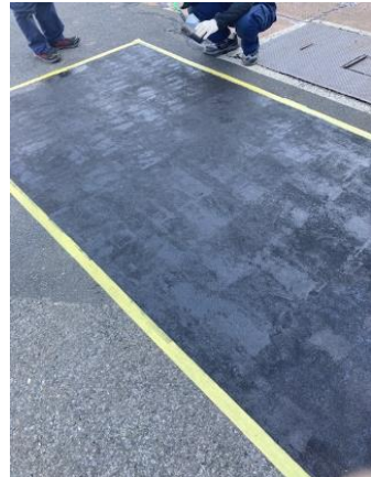
パッチ施工&サンド下地
