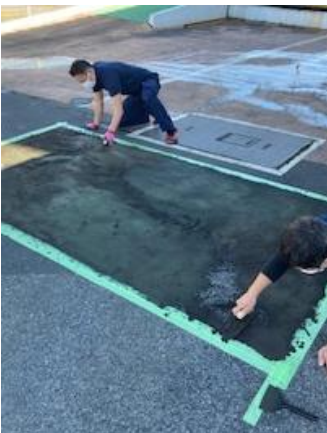
スマートパッチ施工後
